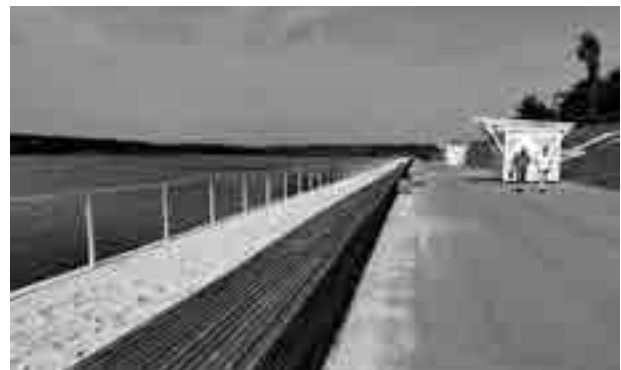
Набережная Яченского водохранилища. Отсутствие мест отдыха для инвалидов с поражением опорно-двигательного аппарата. 08.08.2022
